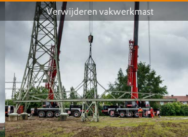
Demontage vakwerkmast met hijskraan
