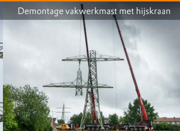
Demontage vakwerkmast met hijskraan
