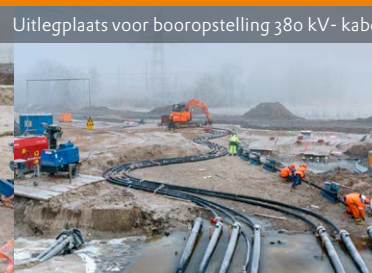
380 kV-kabels aanleggen
