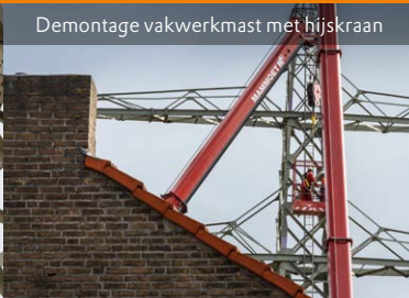
Demontage vakwerkmast met hijskraan
