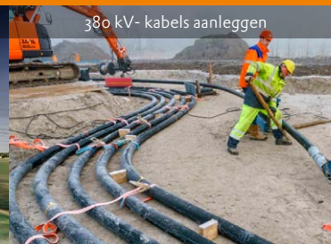
Uitlegplaats voor booropstelling 380 kV-kabels
