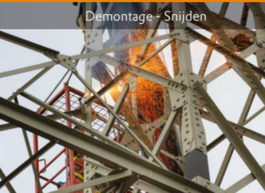
Demontage vakwerkmast met hijskraan
